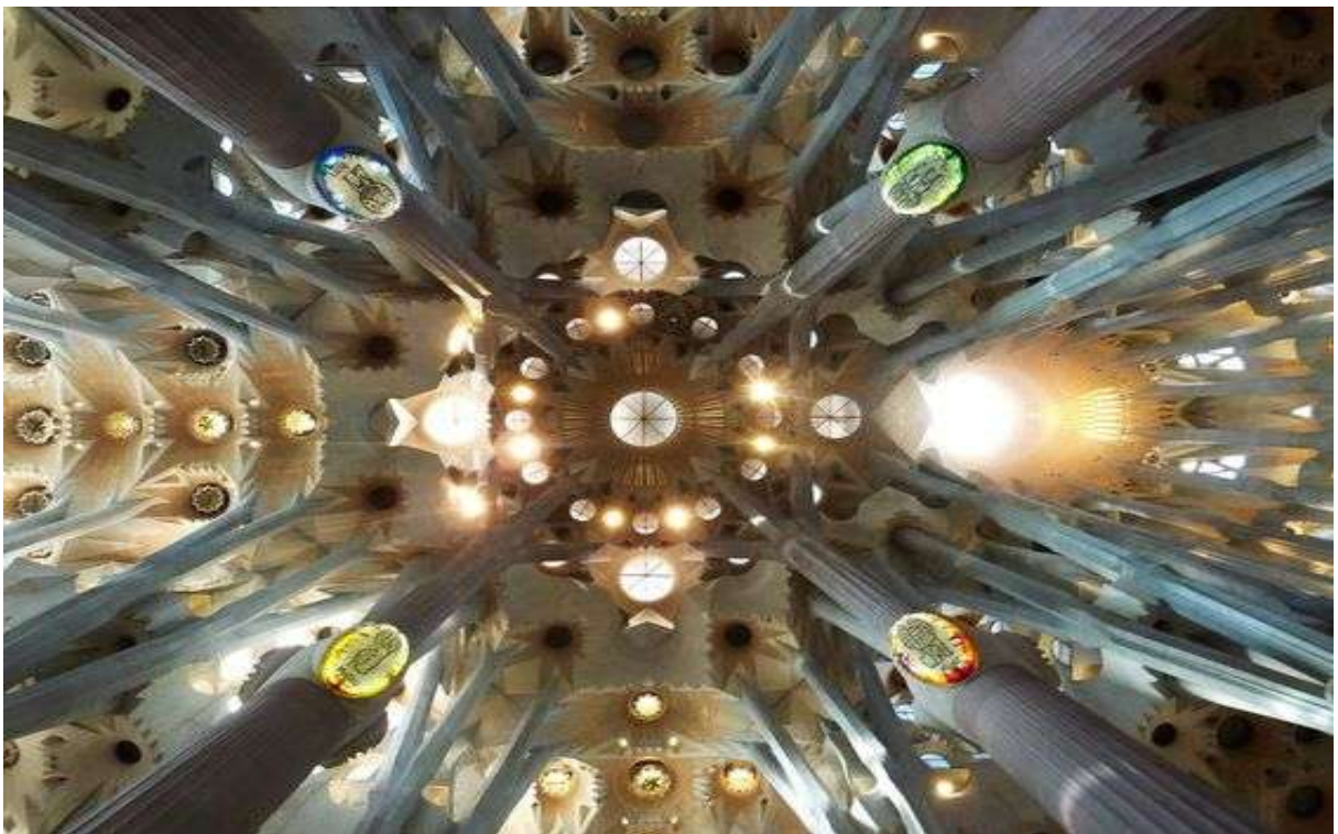
Figura 55 - Bovedas hiperboloides da Sagrada Família
