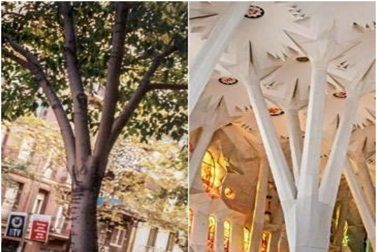
Figura 50 - Coluna de duplo giro
