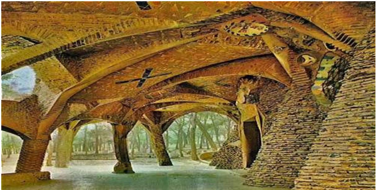
Figura 56 - Cobertura da Cripta Güell
