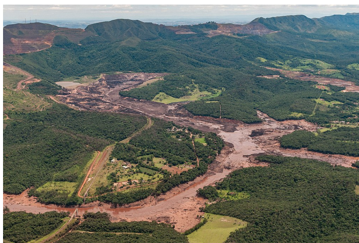
Figura 17 – Rompimento da barragem de Brumadinho
