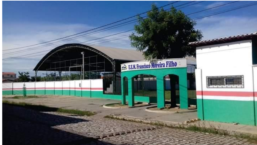
Figura 2 – Fachada da E.E.M. Francisco Moreira Filho
