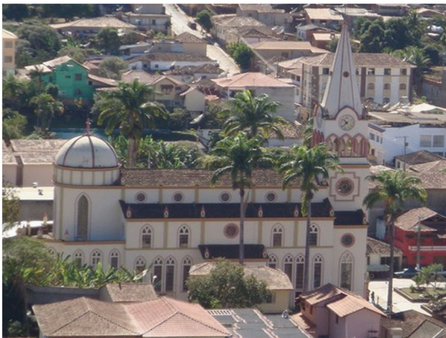
Figura 2.5: Igreja São João Batista de Matipó (1951 - 1957, período da construção)
