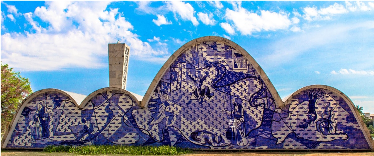
Figura 3.3: Igreja de São Francisco de Assis. Fonte: http://portal.iphan.gov.br/noticias/detalhes/5376/igreja-da-pampulha-reabre-suas-portas-totalmente-restaurada (acesso: 09/11/2019).
