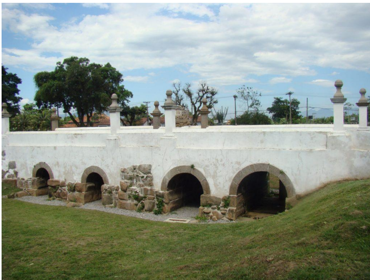
Figura 3 – Ponte dos Jesuítas restaurada.
