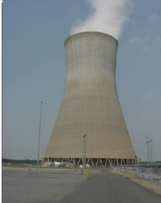
Figura 5.45: Torre de refrigeração de usina nuclear
