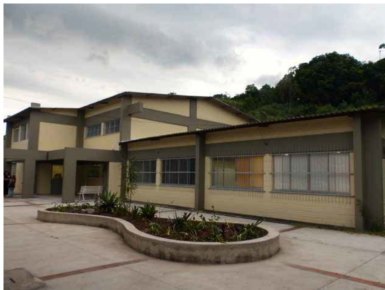
Figura 3 - Novas instalações da FFP, Bloco C
