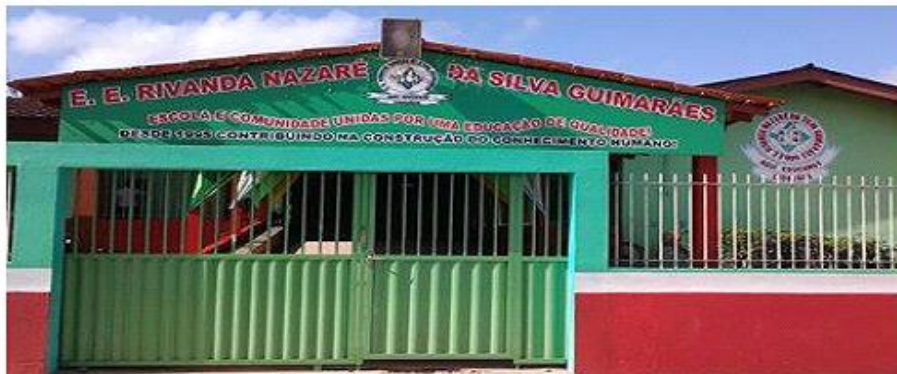
Figura 24 – Entrada Principal da Escola Rivanda de Nazaré.
