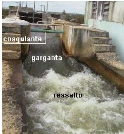
Figura 2.7 – Misturador rápido tipo calha Parshall.
