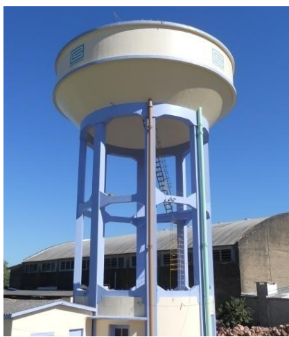
Figura 2.13 – Reservatório elevado no pátio da ETA, em Candelária/RS.
