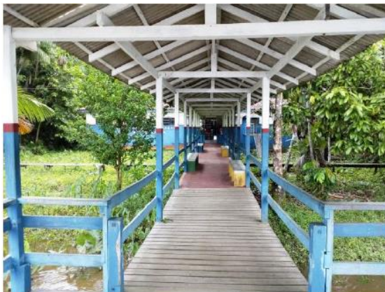
Figura 20 – Passarela de acesso ao interior da escola
