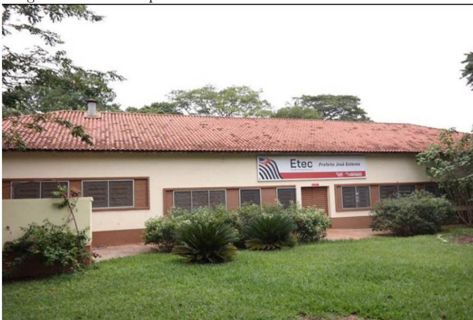
Figura 2.6: Foto do prédio administrativo da ETEC Prefeito José Esteves.
