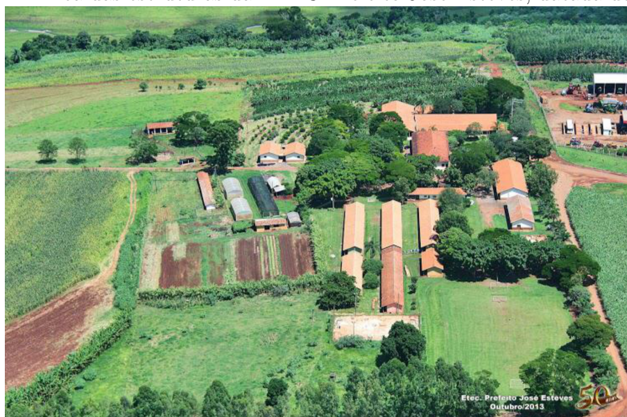
Figura 2.4: Área das estruturas da ETEC Prefeito José Esteves, datada de outubro de 2013
