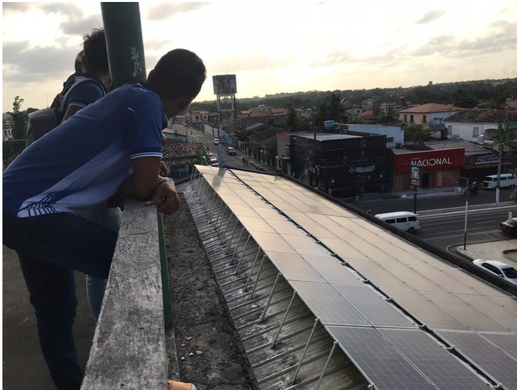
Figura 7 - Visita técnica a estação fotovoltaica da Igreja matriz de Bragança-PA.
