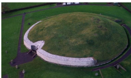
Figura 39: Vista aérea do Newgrange, na Irlanda. 12
