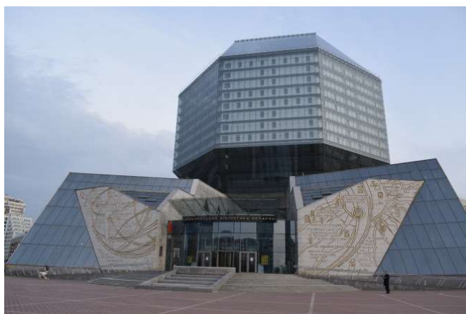
Figura 6-Edifícios de beleza arquitetônica
