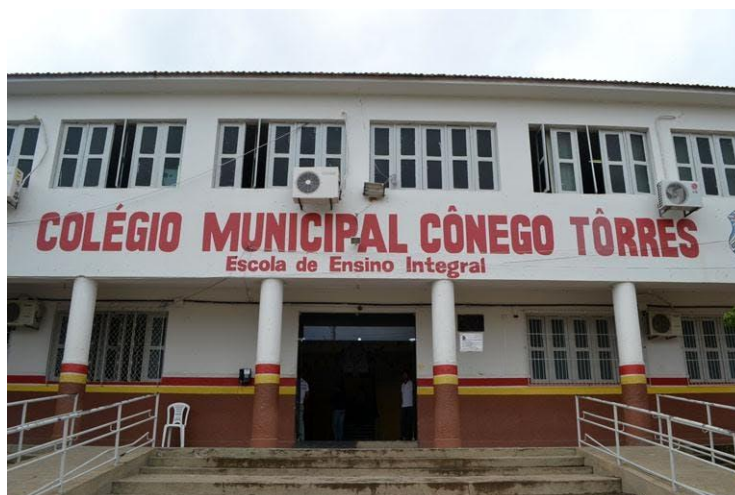
Figura 13 – Fachada do Colégio Municipal Cônego Tôrres em Serra Talhada-PE
