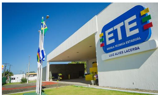
Figura 7- Fachada da ETE Luiz Alves Lacerda – Cabo de Santo Agostinho
