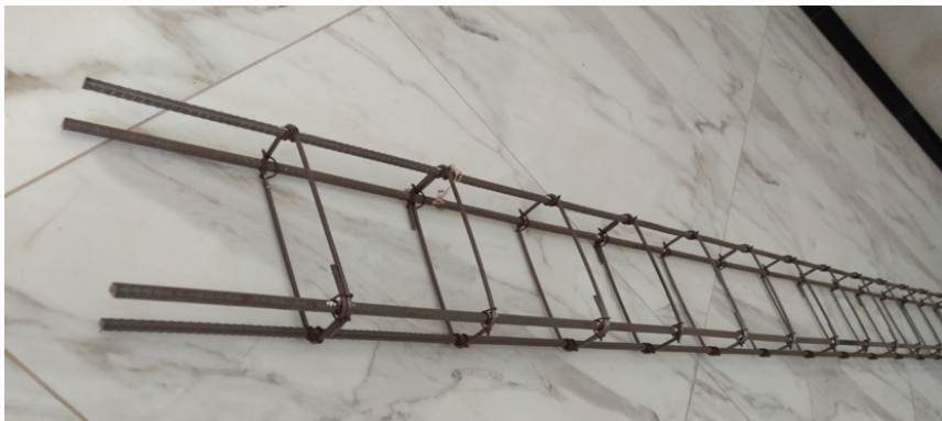
Figura 4.3: Ferragem armada pronta para ser utilizada em uma construção.
