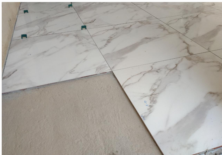
Figura 6.1: Cerâmica sendo instalado no piso.
