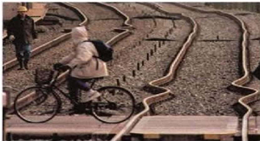
Figura 2 – Trilhos deformados
