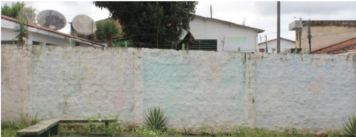
Figura 3 - Muro a ser pintado
