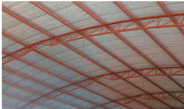
Figura 4: Cobertura do ginásio da escola
