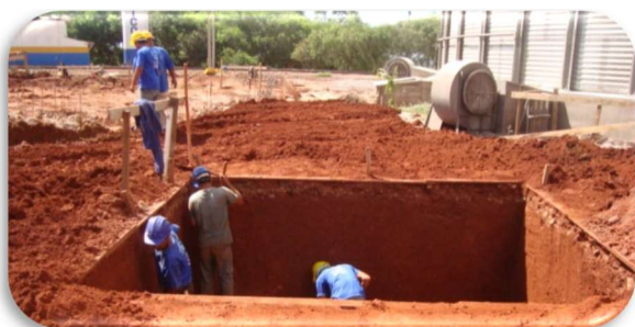
Figura 4. Escavação para tubulações.
