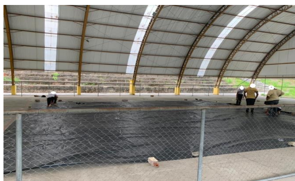
Figura 47 - Montagem da lona na quadra da escola
