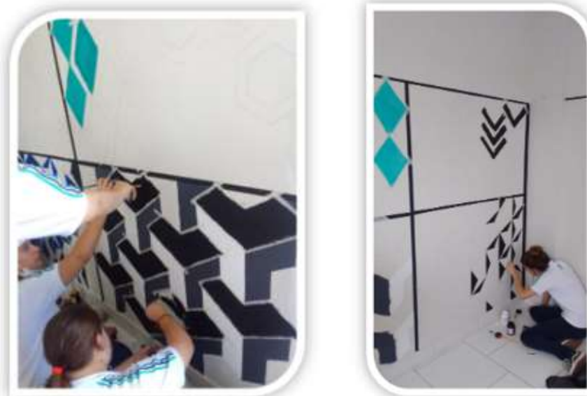
Figura 53 - Acabamento de painéis tesselação
