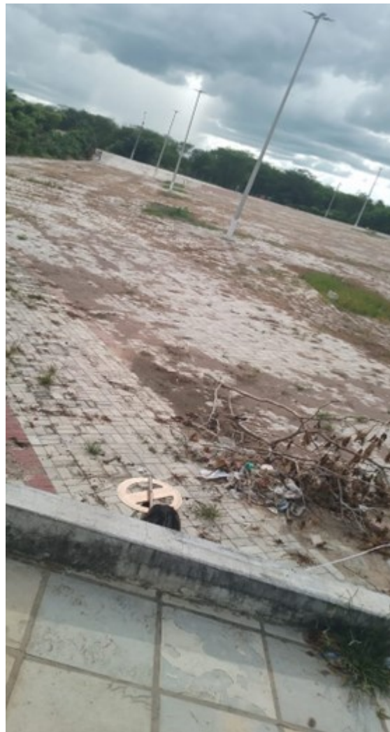
Figura 5.31: Distância entre as pontes.
