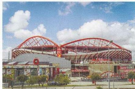
O estádio da Luz localiza-se em Lisboa (Portugal) e tem capacidade para 65 mil pessoas. Recebe esse nome por ter o telhado em policarbonato, suportado por arcos em forma de parábola com 43 metros de altura, permitindo a penetração dos raios solares e iluminando o estádio, ao mesmo tempo que transmite a ideia de flutuar sobre as bancadas onde se assentam.
