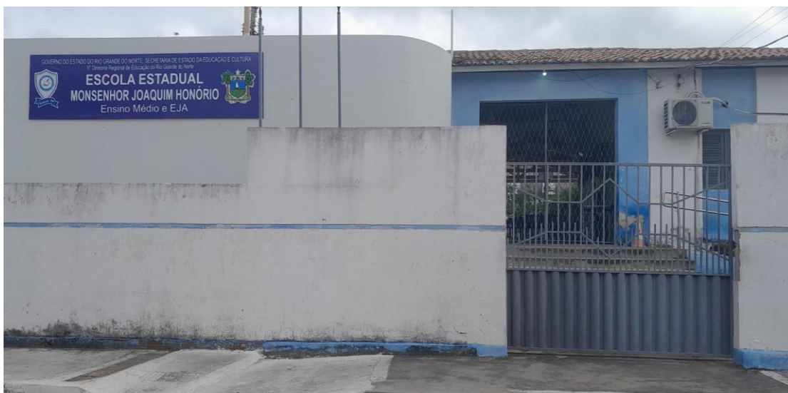
Figura 02. Fachada da Escola.
