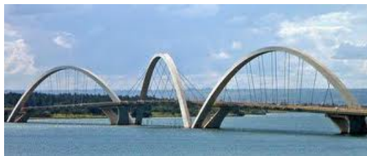
Figura 2.1: Ponte Juscelino Kubitschek - Brasília
