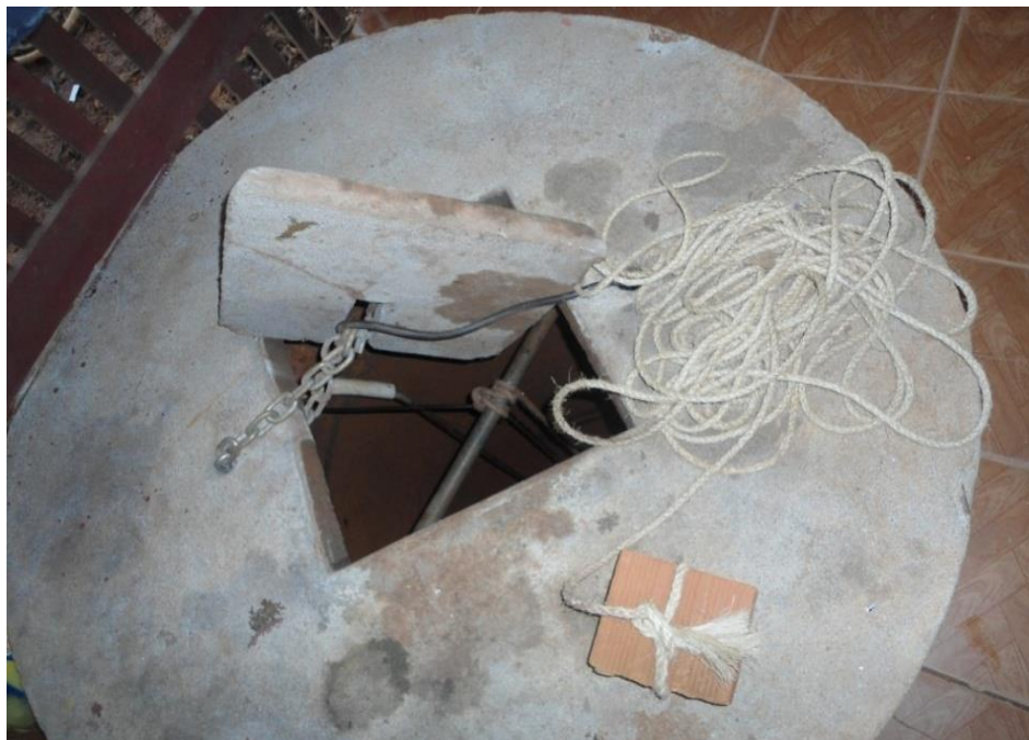
Figura 46 - Corda de medição da profundidade de um poço qualquer.
