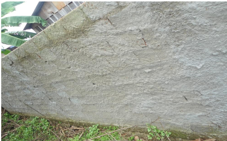
Figura 42 – Muro de tijolos chapiscado.
