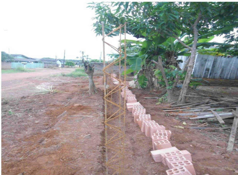
Figura 40 – Base estrutural de um Muro de Tijolos.
